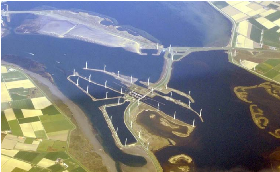
Dankzij inspecties in alle disciplines tot zelfs aan thermografisch onderzoek van elektrotechnische installaties, heeft A-Quin op de Krammersluizen de risico’s vroegtijdig in beeld gebracht (Beeld: Wikimedia Commons / Dkvitg).
