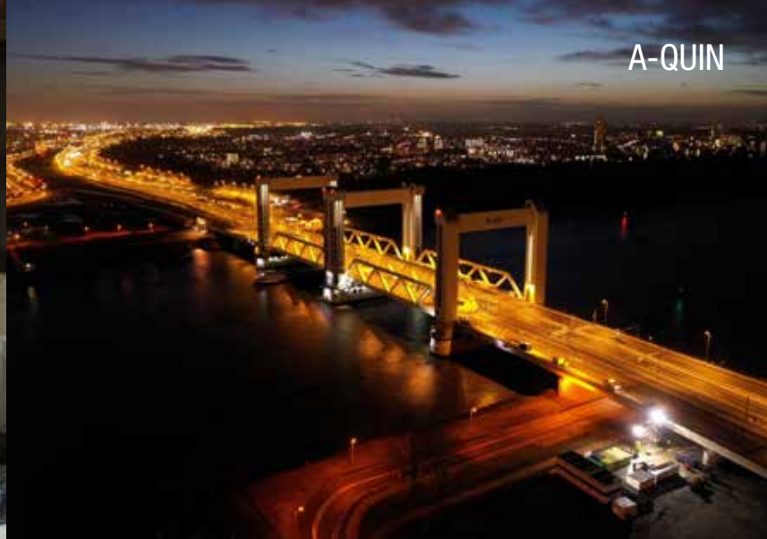
Succesvol assetmanagement van A-Quin in het Rotterdamse havengebied: de Botlekbrug.
